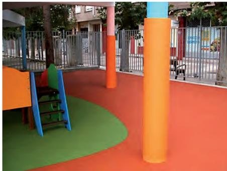
Figura 1.3. **Protección de columnas para minimizar los efectos derivados de golpes o choques contra ellas**
